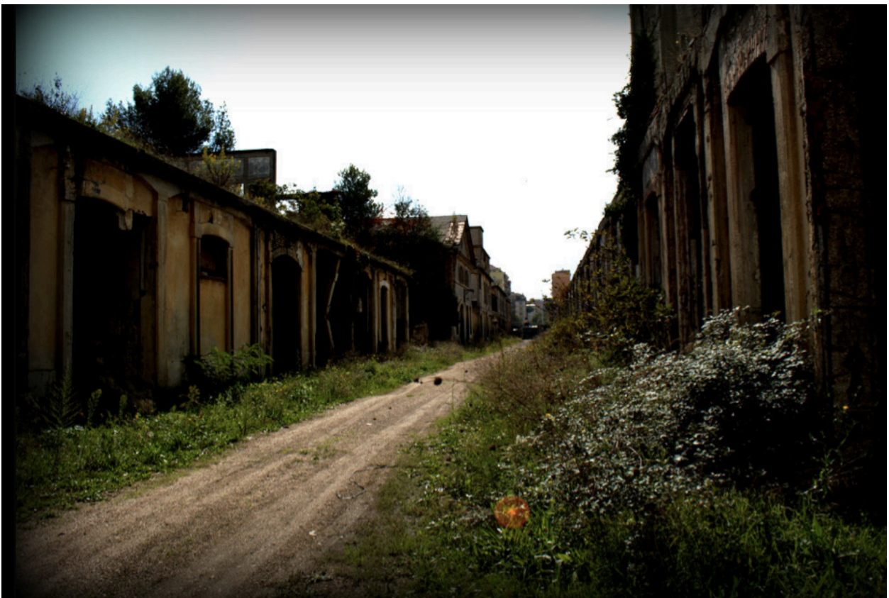
(l'edificio centrale della fabbrica SNIA visto dal viale di distribuzione interno, oggi)
